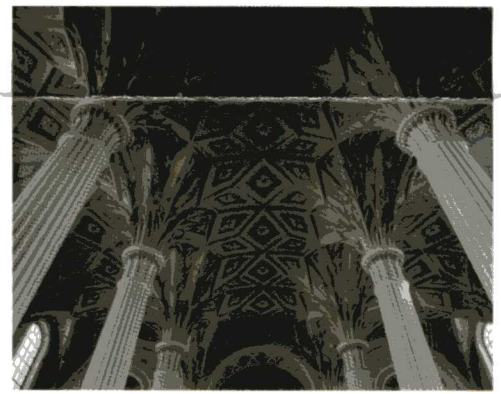
Blick ins Langhausgewölbe der Nikolaikirche
