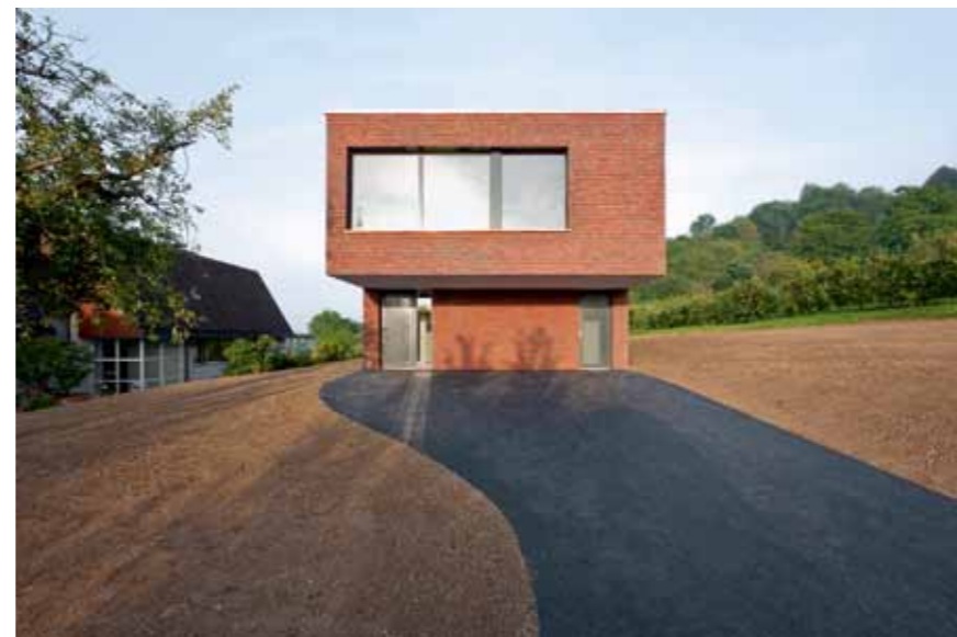
Zufahrt mit Eingangsseite im Osten
